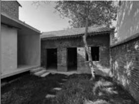
Der Innenhof und die angrenzenden Gebäude vor der Renovierung.
