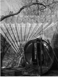
Die hochglanzpolierten, perforierten Edelstahlplatten wurden in Abschnitten vorgefertigt und vor Ort innerhalb von zwei Tagen montiert.
